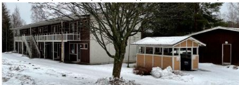
Kuva. Tontin 6319–1 asuintalo, jätekatos ja talousrakennus
